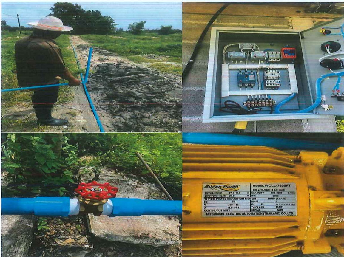
ภาพที่ 26 ติดตั้งระบบน้ำพร้อมปั้มน้ำระบบการควบคุมพื้นที่ 10 ไร่
