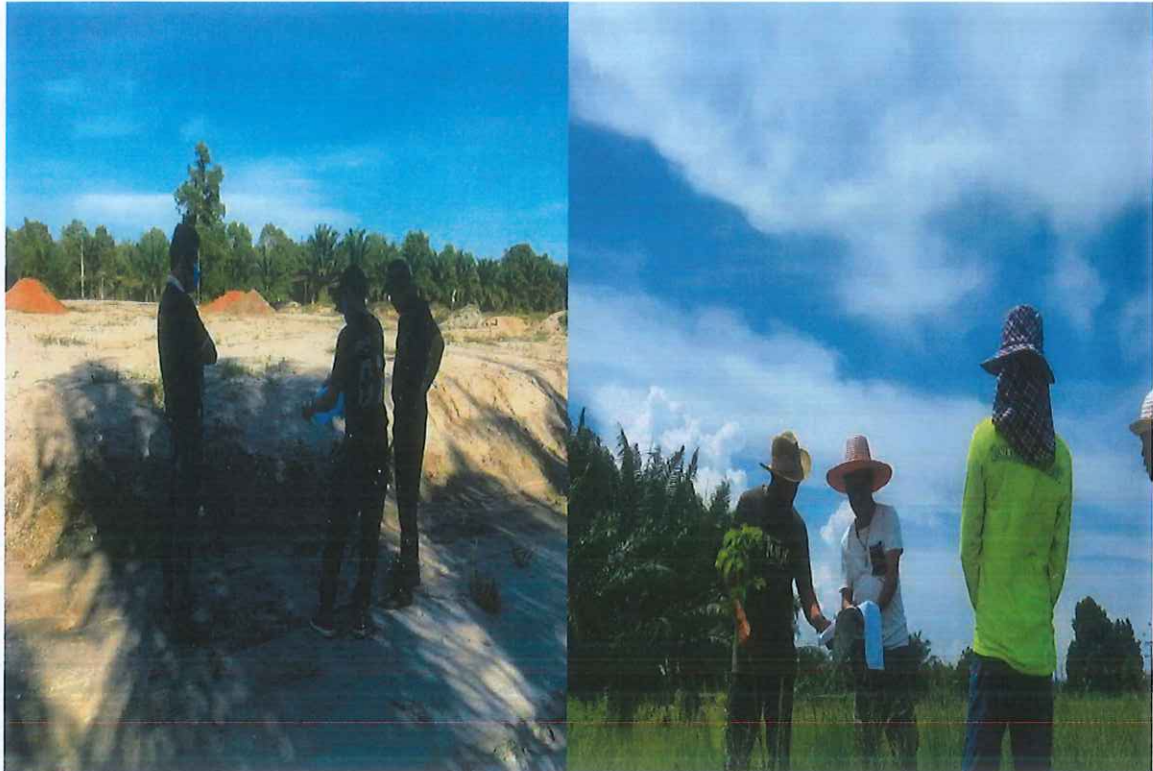
ภาพที่ 25 ตรวจสอบพื้นที่และแปลนการวางระบบน้ำเพื่อเตรียมวางระบบน้ำ
