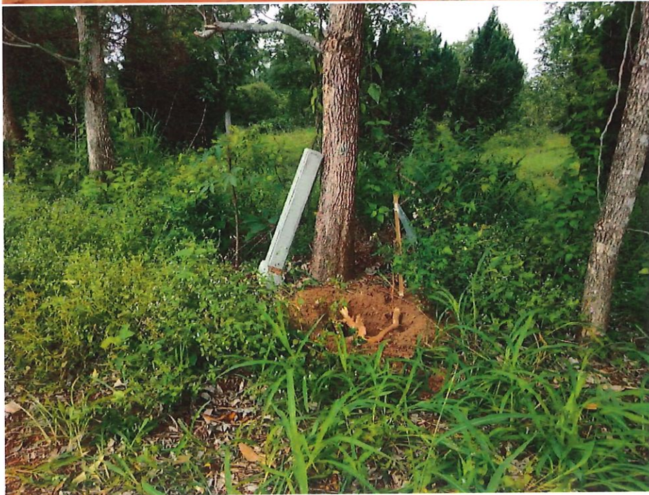
การเจาะดิน สำหรับการฝังหมุดพิกัด
