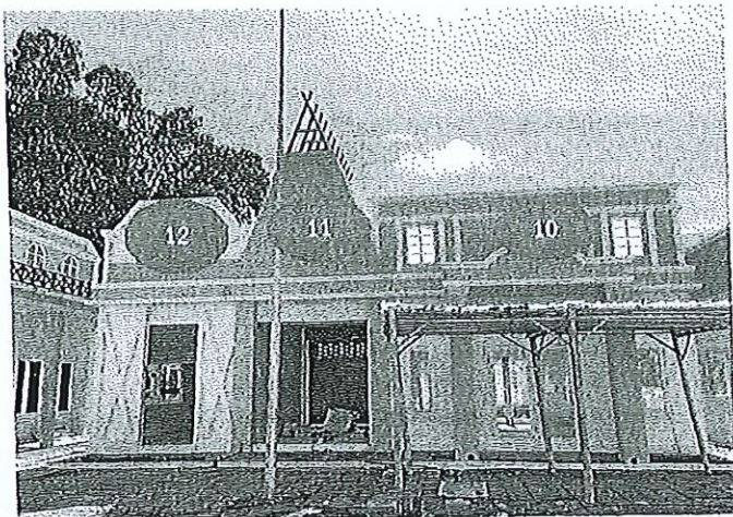
อาคารหลังที่ 7 ขนาดพื้นที่ 63.6 ตารางเมตร (มีห้อง 1ห้อง31.8ตารางเมตร, 2ห้อง15.9ตารางเมตร)
