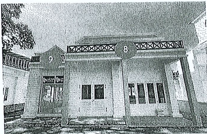
อาคารหลังที่ 6 ขนาดพื้นที่ 47.7 ตารางเมตร (มี 2ห้อง 1ห้อง 31.8 ตารางเมตร 1ห้อง 15.9 ตารางเมตร)
