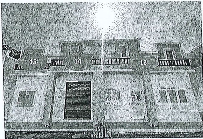
อาคารหลังที่ 8 ขนาดพื้นที่ 63.6 ตารางเมตร (มีห้อง 1ห้อง31.8ตารางเมตร, 2ห้อง15.9ตารางเมตร)
