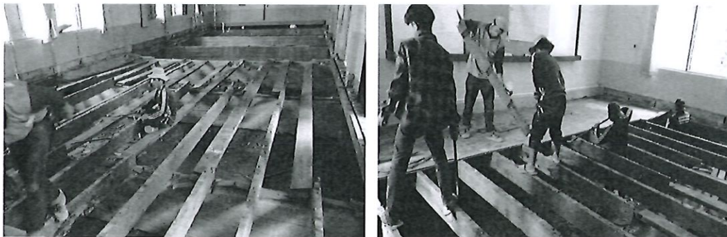
รูปที่ 9 แสดงขั้นตอนการรื้อถอนไม้พื้น
