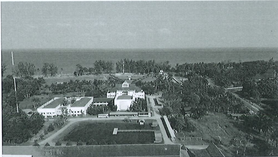
ภาพที่ 11 ตัวอย่างหลังคาอาคารที่จะใช้สำหรับติดตั้งระบบผลิตไฟฟ้าพลังงานแสงอาทิตย์บนหลังคา (Solar rooftop) มหาวิทยาลัยแม่โจ้ - ชุมพร
