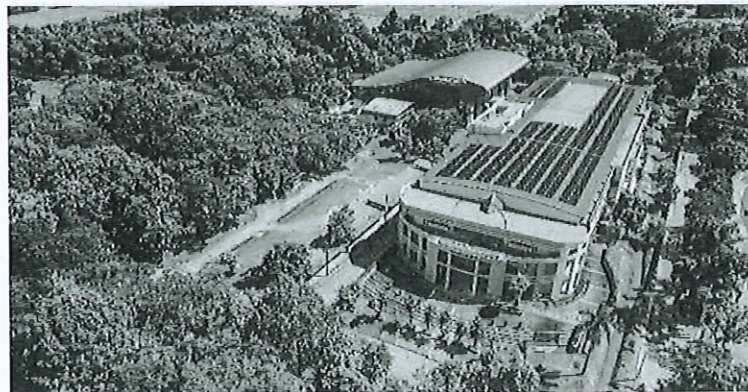
ภาพที่ 8 ระบบผลิตกระแสไฟฟ้าพลังงานแสงอาทิตย์บนหลังคา อาคารอำนวยการ ยศสุข
