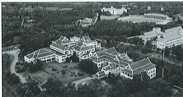
ภาพที่ 10 ตัวอย่างหลังคาอาคารที่จะใช้สำหรับติดตั้งระบบผลิตไฟฟ้าพลังงานแสงอาทิตย์บนหลังคา (Solar rooftop) มหาวิทยาลัยแม่โจ้ - แพร่ เฉลิมพระเกียรติ
