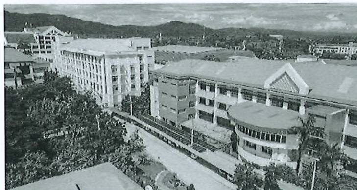
ภาพที่ 6 ระบบผลิตกระแสไฟฟ้าพลังงานแสงอาทิตย์บนหลังคา คณะเศรษฐศาสตร์
