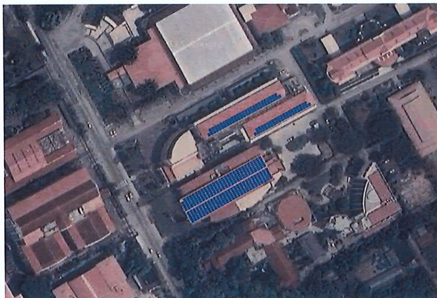
รูปที่ 3 ภาพถ่ายดาวเทียมแสดงพื้นที่ตั้งของโครงการติดตั้งบนหลังคา ขนาดกำลังการผลิต 405.37 กิโลวัตต์ ( อาคาร 75ปี และอาคารจุฬารักษ์ )
