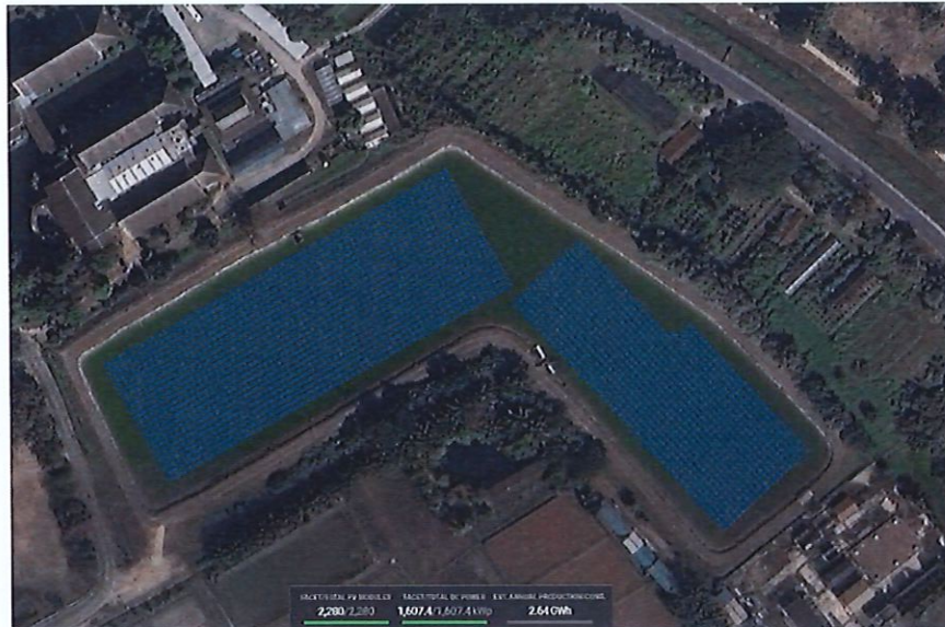
รูปที่ 2 ส่วนขยายแสดงพื้นที่ตั้งของโครงการติดตั้งแบบทุนลอยน้ำ ขนาดกำลังการผลิต 1,607.4 กิโลวัตต์ ( สระเก็บกักน้ำ ของมหาวิทยาลัย )
