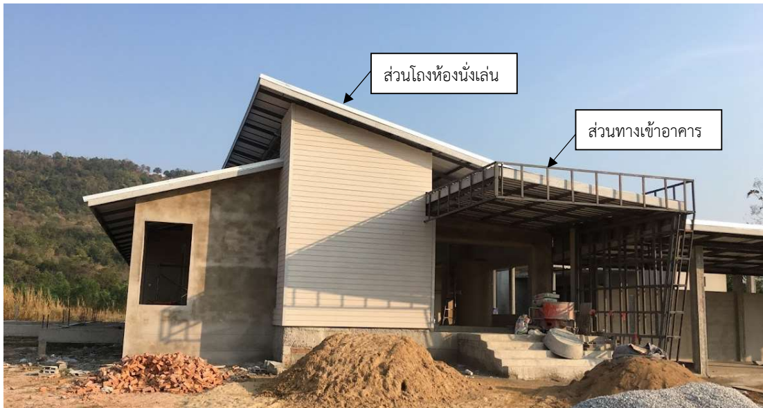
ภาพ 11 แสดงช่วงก่อสร้างอาคารแสดงให้เห็นถึงวัสดุที่ใช้ในการออกแบบอาคาร
